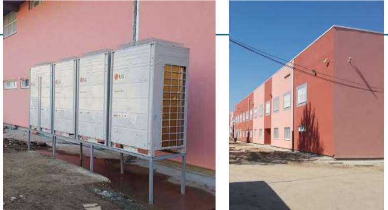
Kazneno popravni zavod Niš
